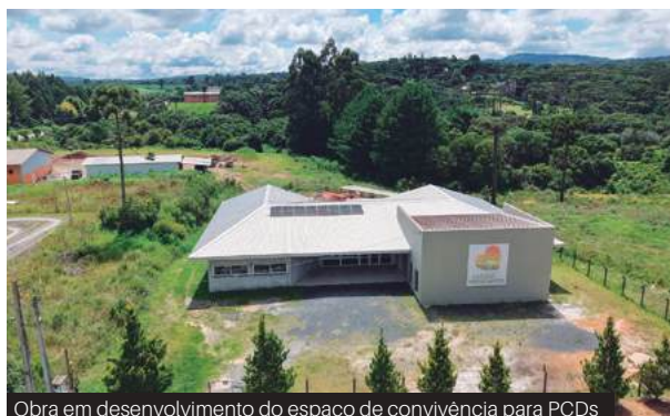
Obra em desenvolvimento do espaço de convivência para PCDs
