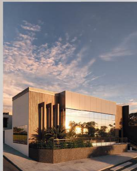
SALA COMERCIAL RUA CAMPOS SALLES FASE FINAL DE ACABAMENTO
